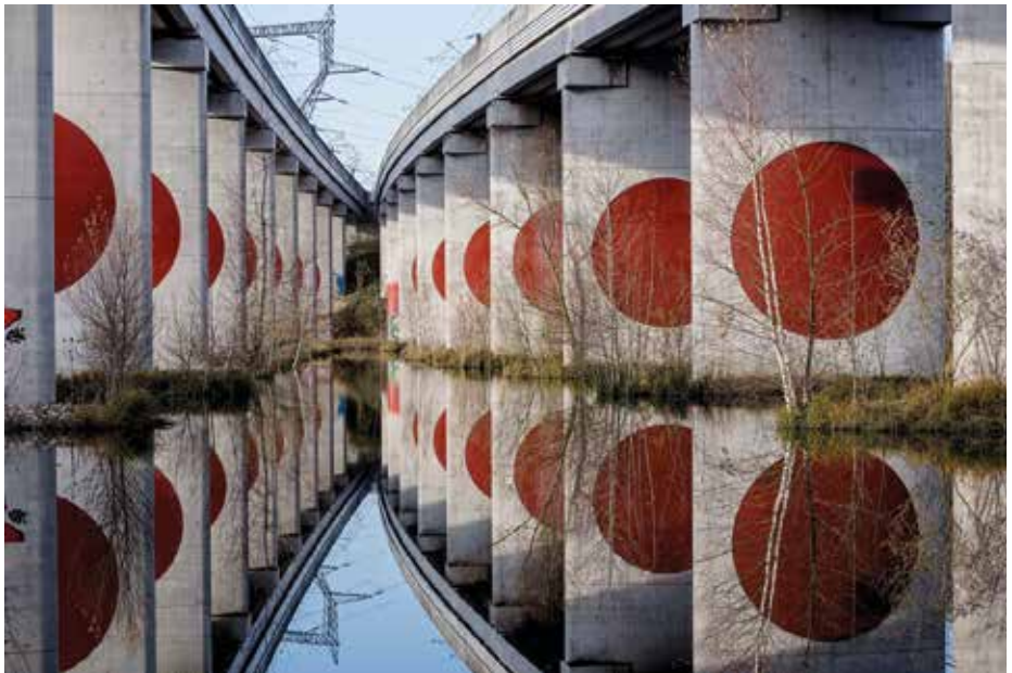
Piliers du double viaduc ferroviaire de la ceinture LGV nord-est de Paris (Claye-Souilly). Photo Pierre-Yves Brunaud, 2018.
